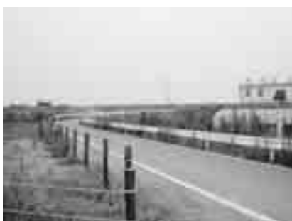
市道幹18号付け替え道路
