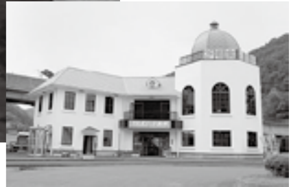
被災前の島越駅舎
