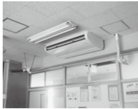
エアコン設置
