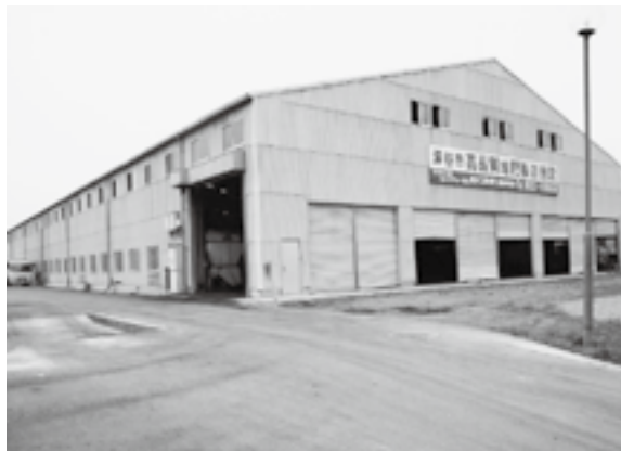
堆肥センター
