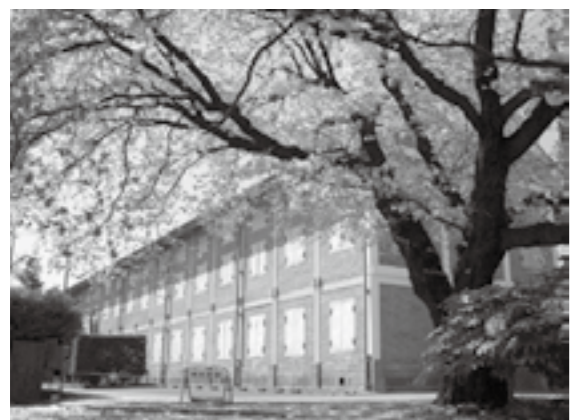
富岡製糸場 (画像提供 富岡市・富岡製糸場)
