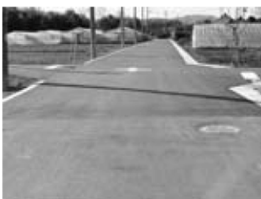
改良された道路
