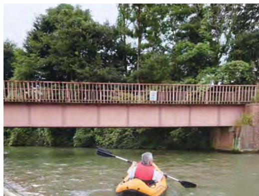
備前渠用水路の鉄橋
