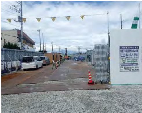
原郷上野台線汚水管・雨水管切り直し工事現場
