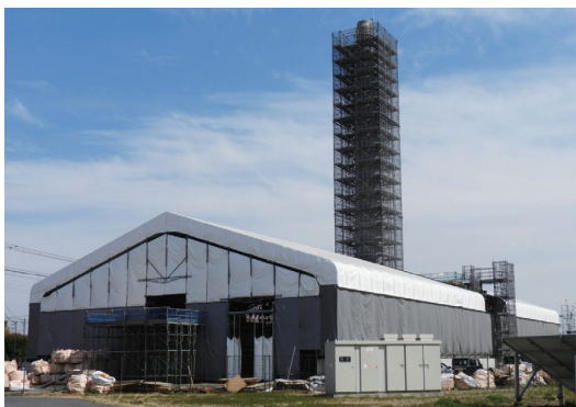
ホフマン輪窯6号窯外観
