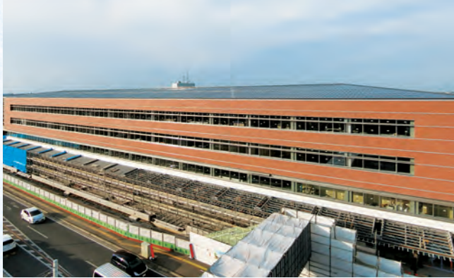
建設中の新庁舎
