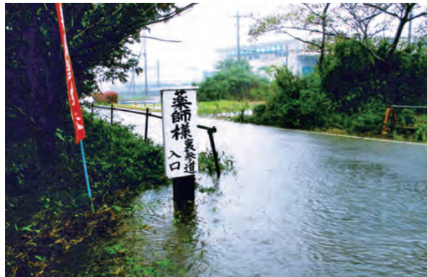
台風時の瀬山薬師堂周辺部
