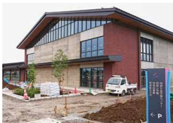
建設中の岡部公民館
