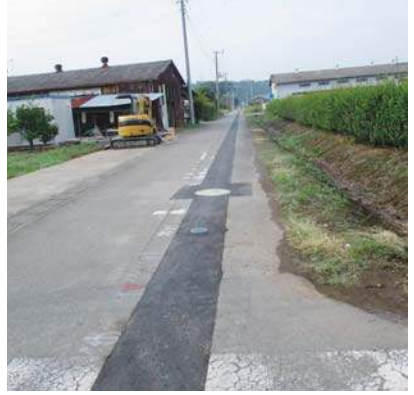
水道管敷設替え
