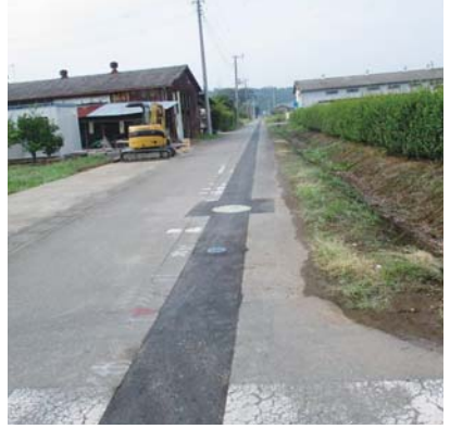
水道管敷設替え
