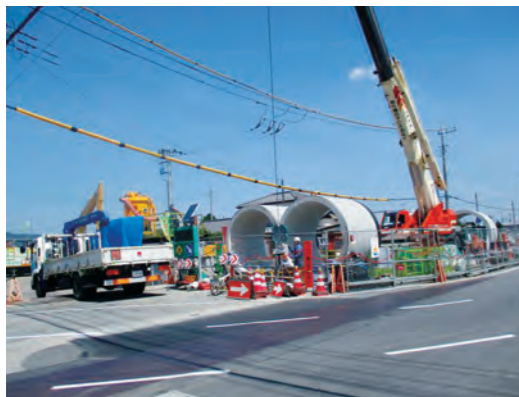
小前田第5雨水幹線工事
