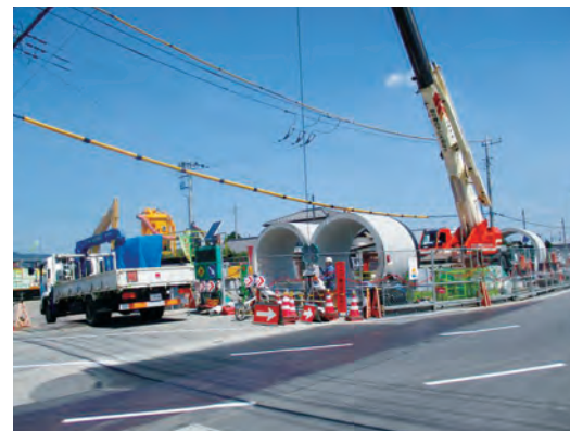
小前田第5雨水幹線工事
