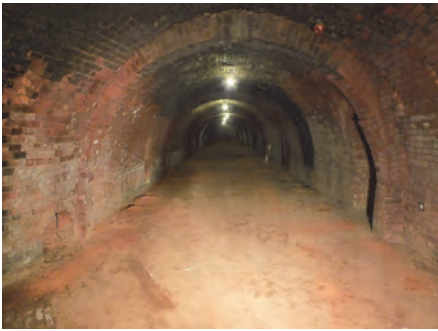
ホフマン輪窯の内部（深谷市上敷免）
