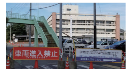
市役所前の市道は建設準備のため 通行止めになりました
