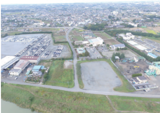
川本公民館建設予定地付近
