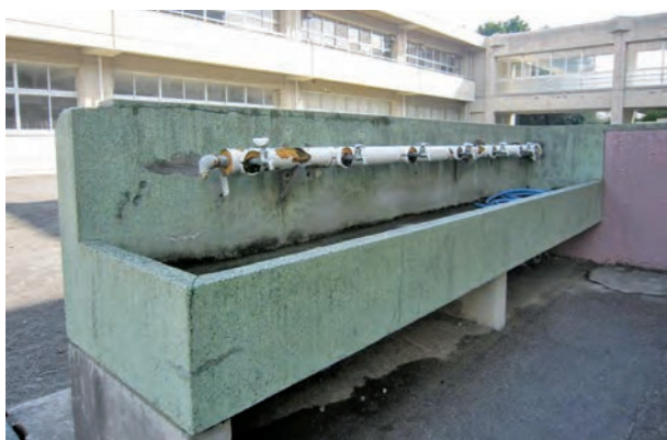
市内小学校 外水道
