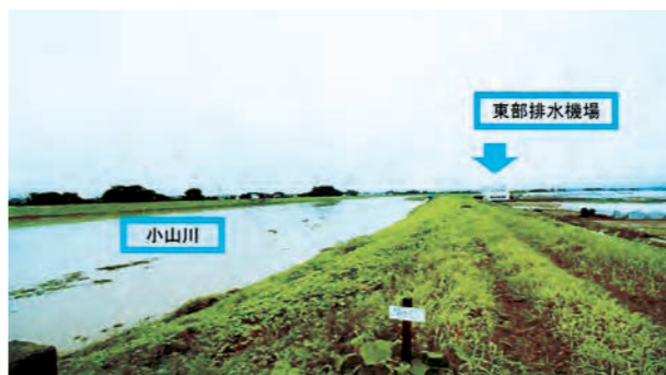
豊里東部排水機場 平成23年9月小山川増水 (八基・豊里地区が内水により大きな被害を受けた)
