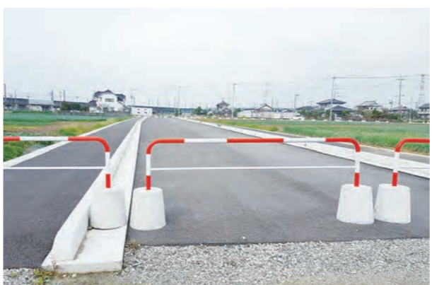
榛沢通り線新設箇所（後榛沢市内）
