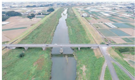
小山川 新明橋付近
