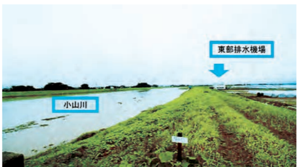
豊里東部排水機場 平成23年9月小山川増水 (八基・豊里地区が内水により大きな被害を受けた)
