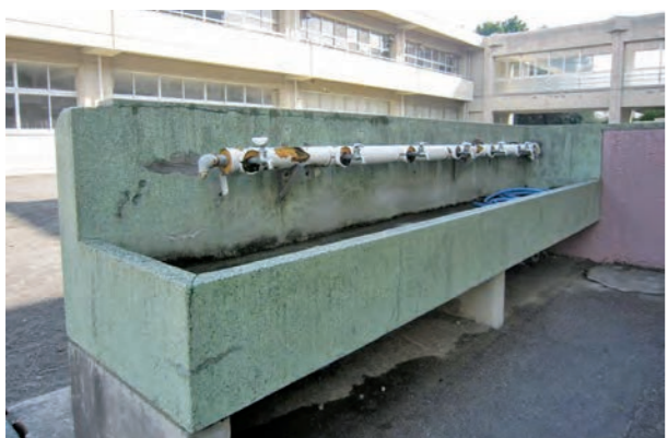
市内小学校 外水道
