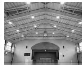
つり天井工事後
