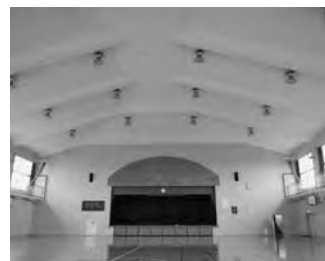
つり天井工事前
