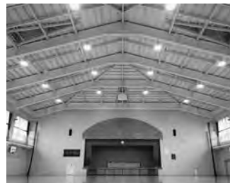
つり天井工事後
