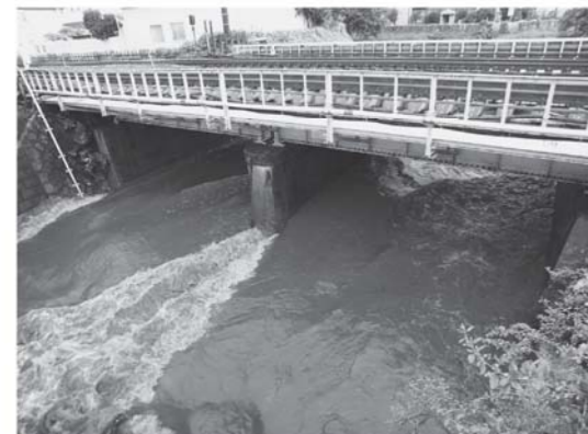
唐沢川の高崎線橋脚
