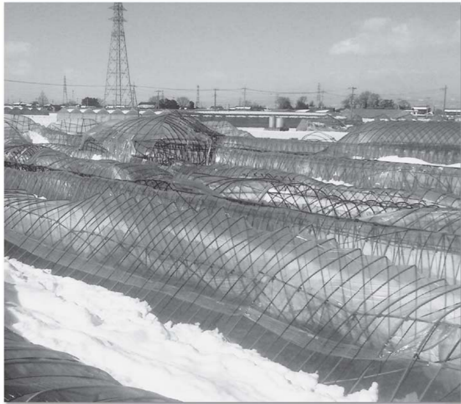
ビニールハウス再建前
