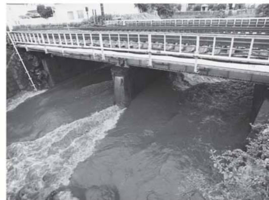
唐沢川の高崎線橋脚
