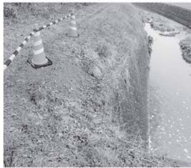
吉野川陥没箇所（復旧工事後）
