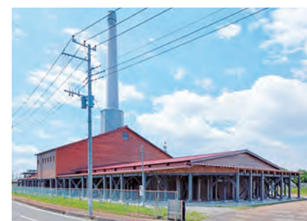
保存修理終了後のホフマン輪窯外観
