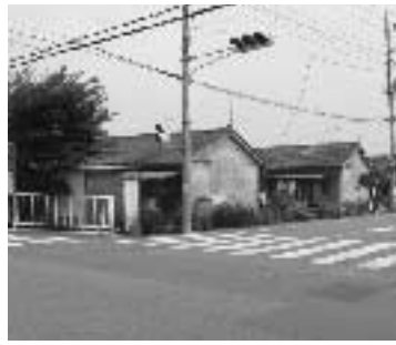
見晴町市営住宅
