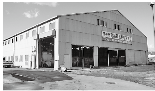
堆肥センター
