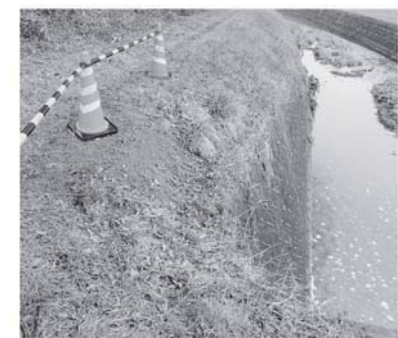
吉野川陥没箇所（復旧工事後）
