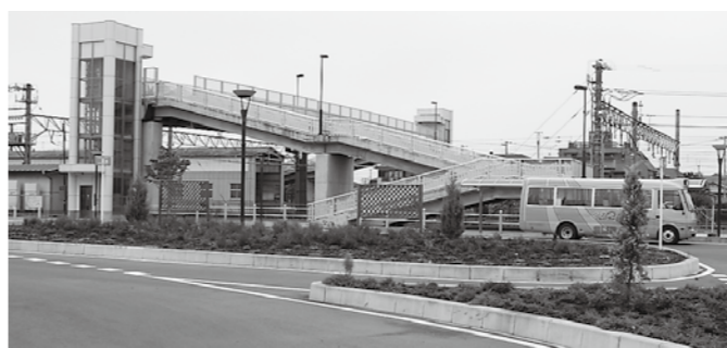
武川駅前広場・跨線橋
