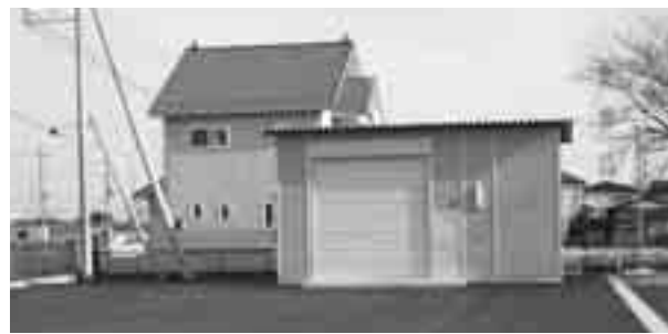
防災倉庫 (田谷地区)
