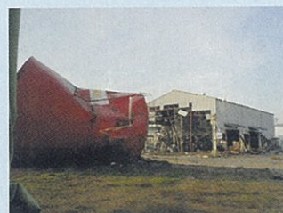
▲巨大タンクも津波で倒壊
