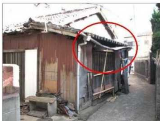
雨樋が壊れており、機能的には 雨樋はないと同様の例 (評点10点)
