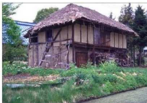
屋根材がワラの例 (評点10点)
