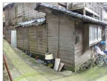
外壁が裸木造の例
