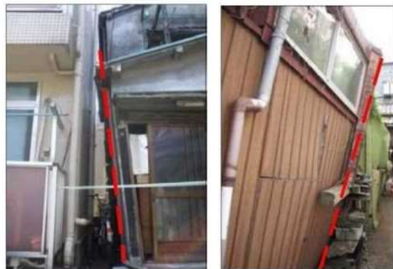
柱の変形が著しく崩壊の危険がある例 (評点100点)
