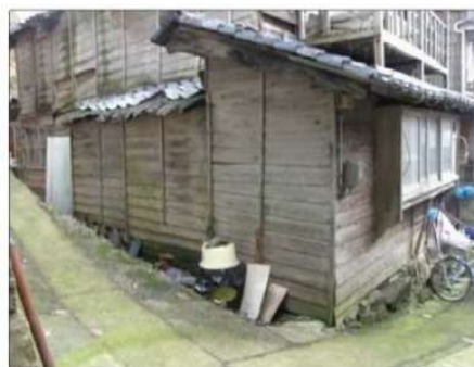
外壁が裸木造の例
