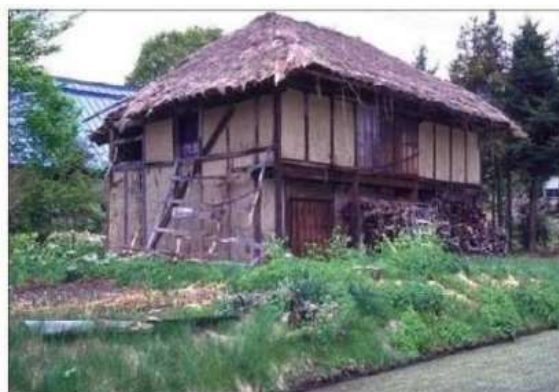
屋根材がワラの例 (評点10点)
