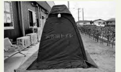
▲災害用マンホールトイレの設備
