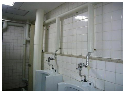
不具合により修繕を行ったトイレ
