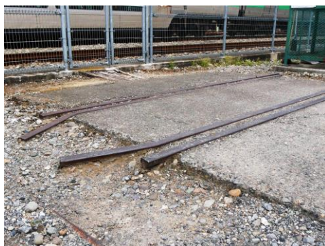
東方地内に残るレール。踏切跡か？
