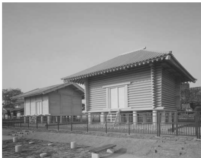
2号建物（奥） 1号建物（手前）
