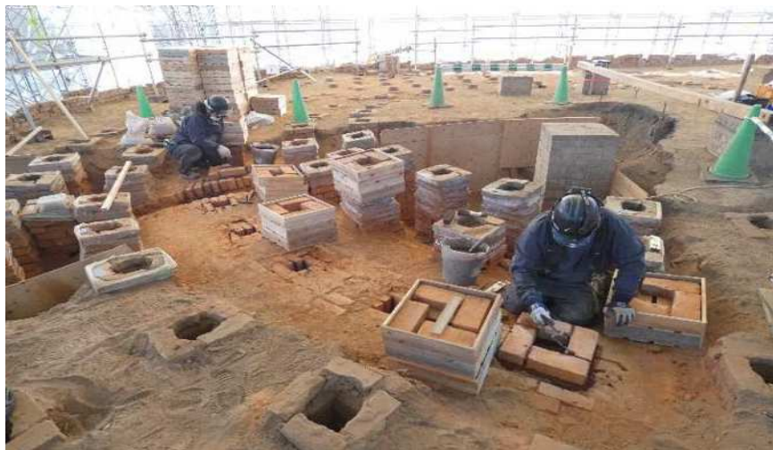
ホフマン輪窯6号窯保存修理工事
