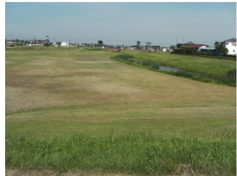
清水川調節池
