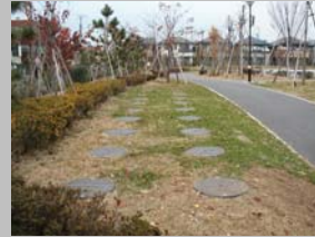
防災機能を備えた公園 (写真：地下式非常用屋外トイレ(千葉県))
