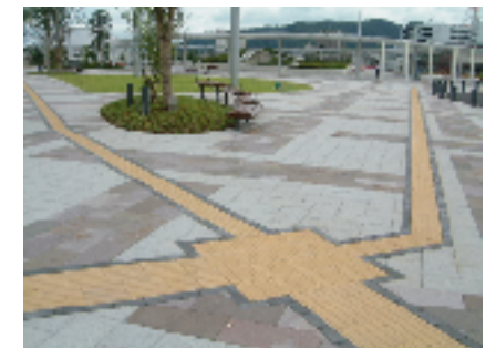
適切に設置された 視覚障害者誘導用ブロック
