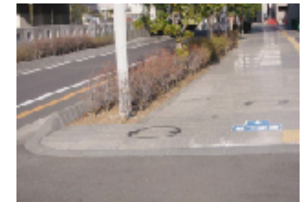
セミフラット歩道
