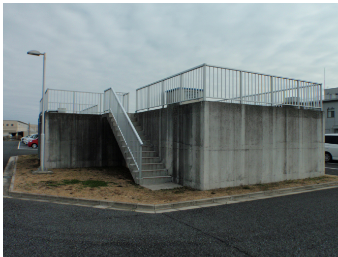
岡部浄水場内 洗浄排水池
