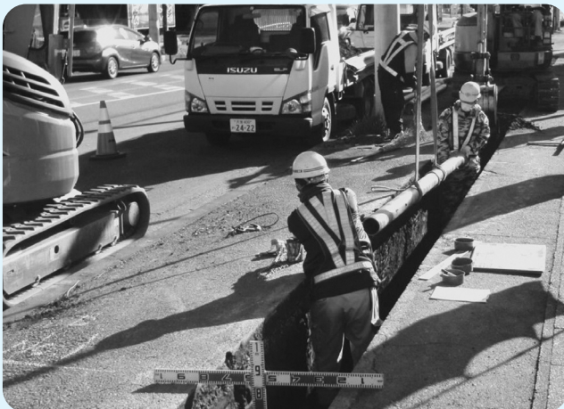
水道管布設替工事の様子
