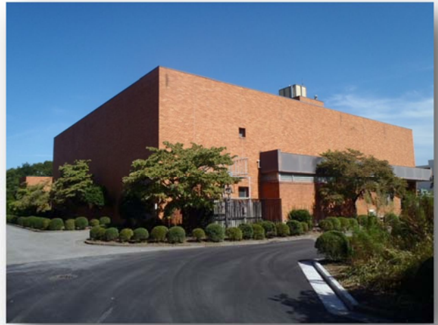
○沈砂池ポンプ棟
