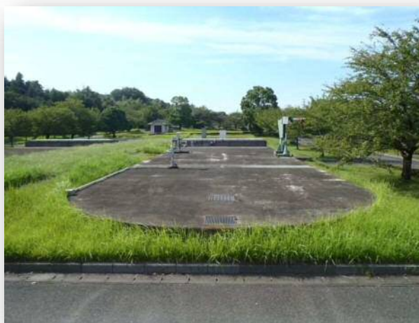
○オキシレーションディッチ
