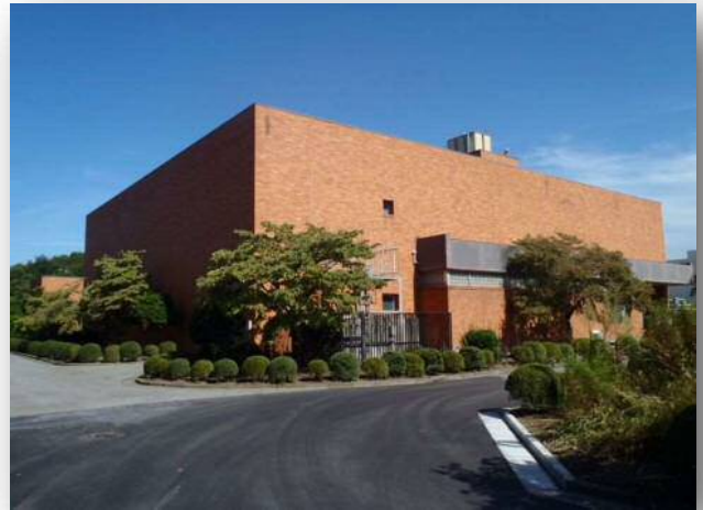
○沈砂池ポンプ棟
