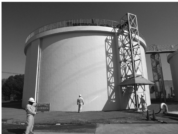
完成した No. 2 配水池
